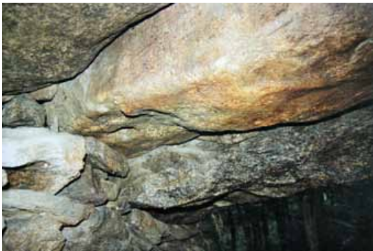
Die Lochsteine in der Brücke von unten gesehen
